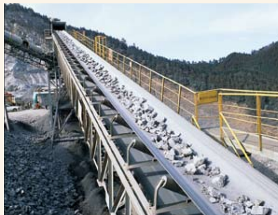
碎石プラントで活躍するコンベヤベルト
