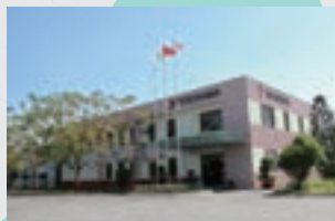
ベトナム工場外観
