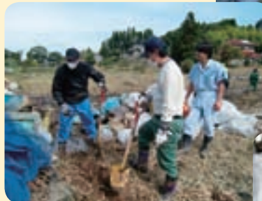
排水溝を作り作業効率を上げる
