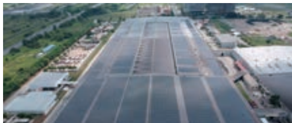
設置された太陽光発電システム
