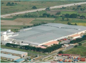
YTPHIの本社・工場
