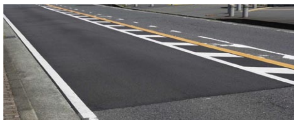
公道テストの施工現場(色の濃い部分)
